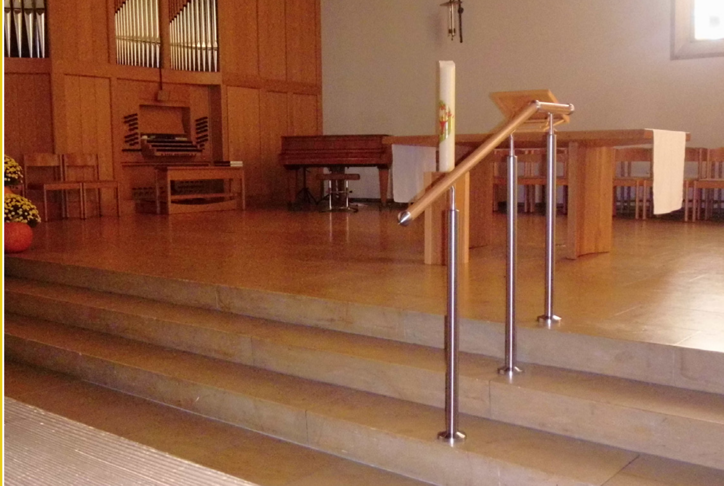
Mit Liebe zum Detail wurde ein Handlauf in einer Kirche als Zugang zum Altarraum installiert
