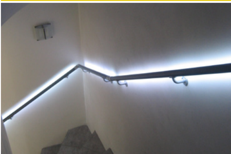
Durchlaufende Beleuchtung für innere Handläufe
