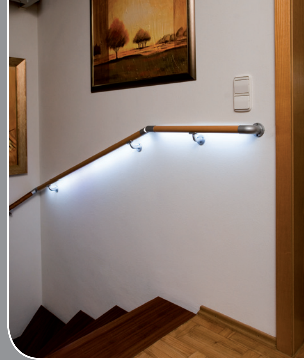
Mehr Sicherheit an der Treppe bei Tag und Nacht
