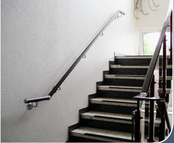
Hotel, nachgerüstet nach Norm, passend zum inneren Geländer
