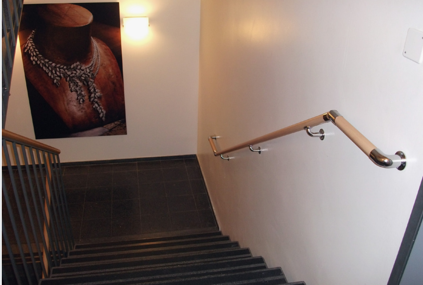
Nachgerüstet zum vorhandenen Handlauf in einem grossen Industrieunternehmen der Schmuckbranche
