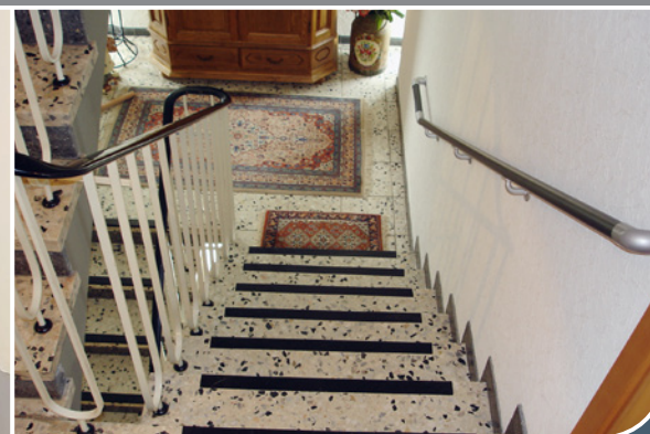
Gästehaus, nachgerüstet mit Wandhandlauf
