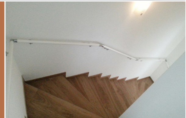
Richtiger Treppenverzug bei einer 2 x 1/4-gewendelten Treppe
