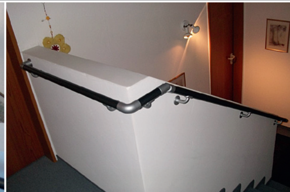
Durchlaufender Handlauf auch an der Brüstung
