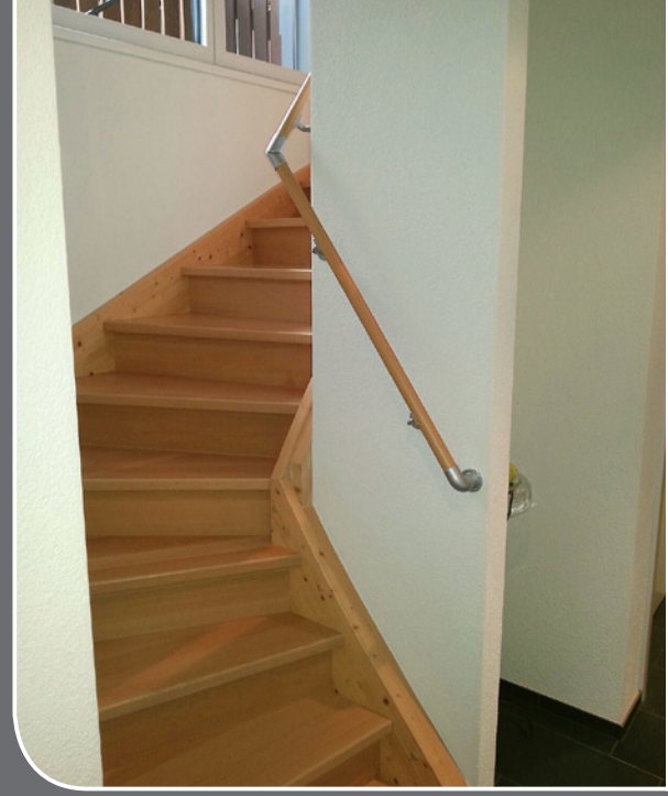
Handlauf an der Innenseite, da aussen Fenster und Brüstung
