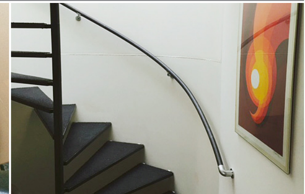
Geschwungener Handlauf in einem Treppenturm
