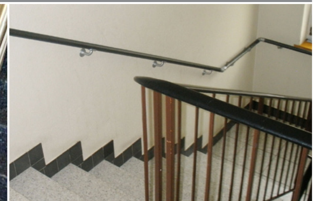
Wandhandlauf nachträglich montiert
