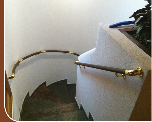
Beidseitiger Handlauf an einer runden Treppe
