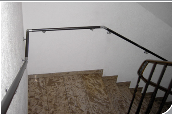
Industriegebäude: nachgerüstet in Schwarz/Silberstreif
