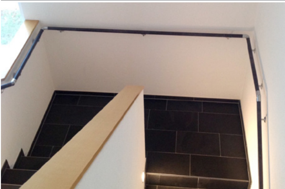
Handlauf wandseitig über die Podeste ergibt hohe Sicherheit
