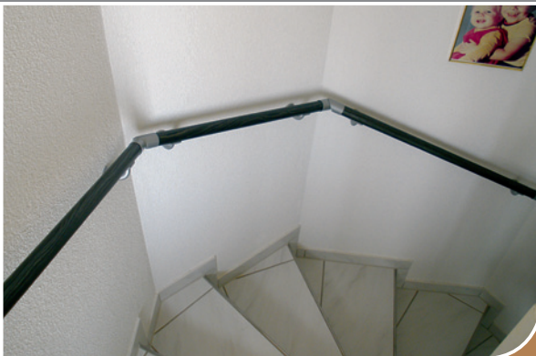
Gebrochene Ecken mit taktilem Verbindung
