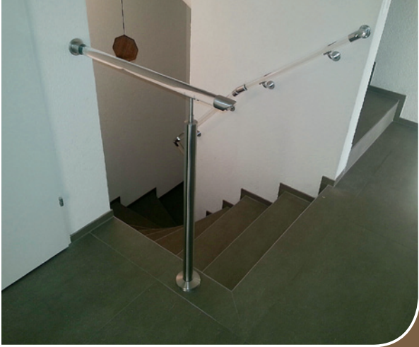
Handlauf aus Plexiglas mit Stützen in Chromstahl
