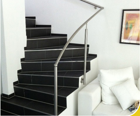
Kompletter Handlauf in Edelstahl, 35 mm, geschwungen
