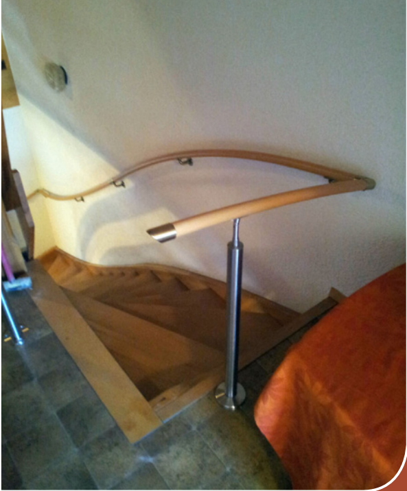
Handlauf in Buche, als Sonderkonstruktion zum Geländer passend
