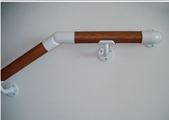
30 cm über die letzte Stufe geführt und mit Abschlussbogen
