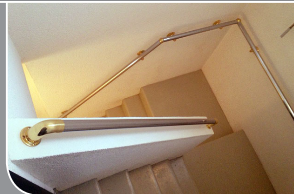
Mauerbrüstung und Wandhandlauf
