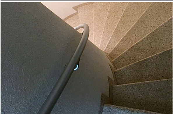
Schön geschwungener durchlaufender Handlauf
