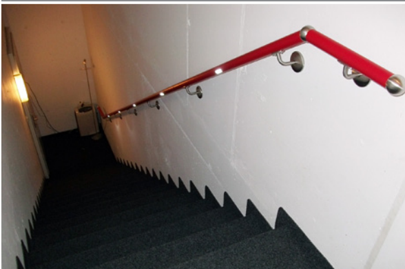
Roter Handlauf mit Licht und taktilen Kugeln
