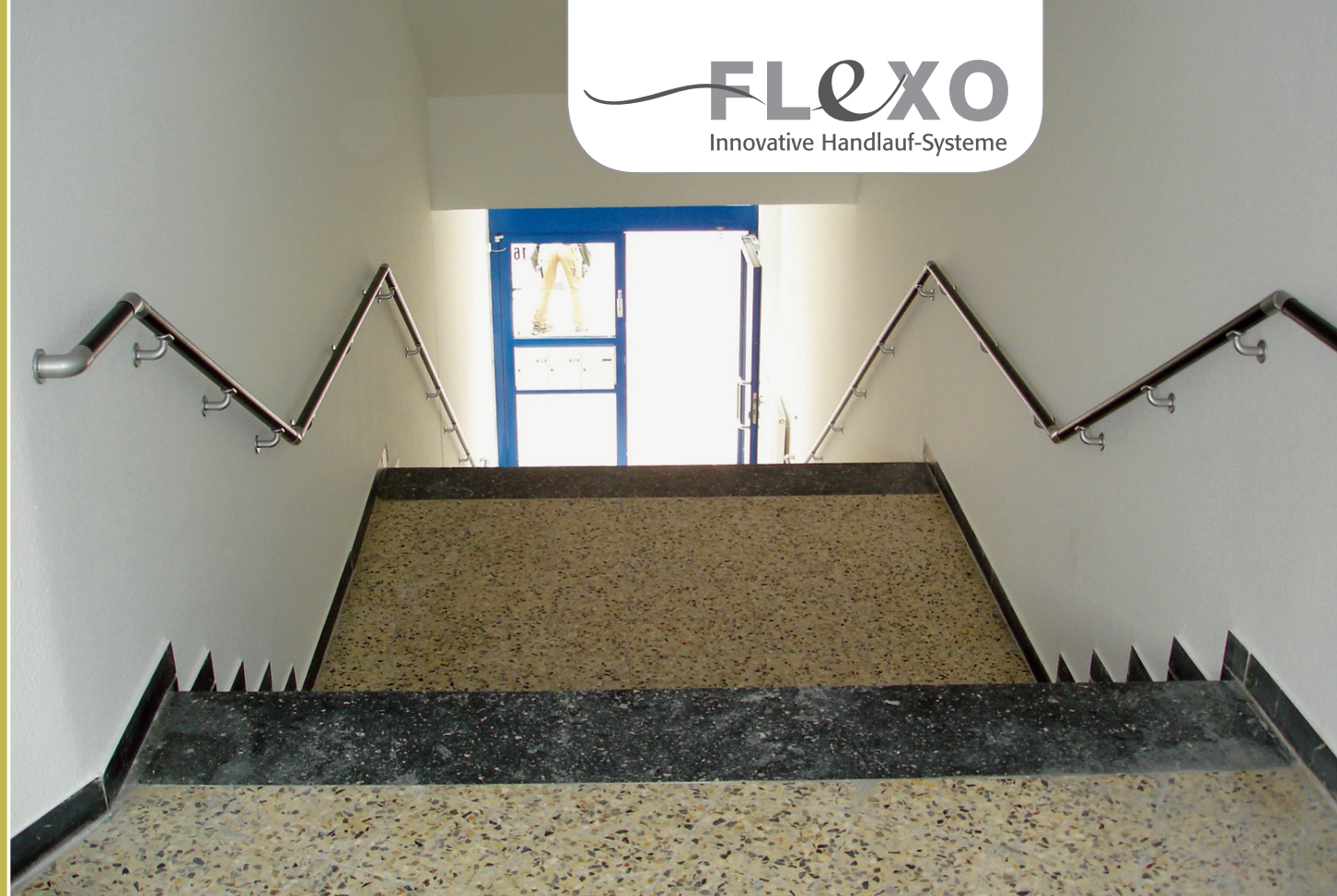
Beidseitige Handläufe im Eingang eines Wohn- und Geschäftshauses
