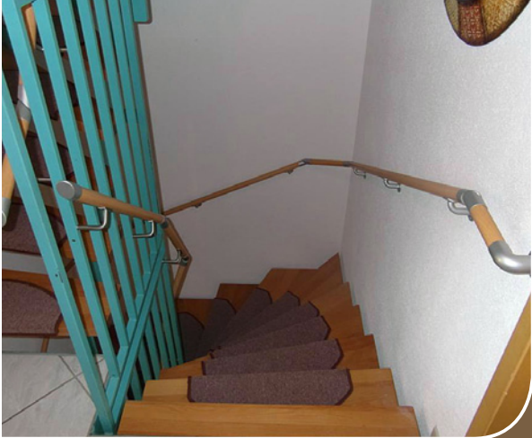
Beidseitiger Handlauf an einer gewendelten Treppe
