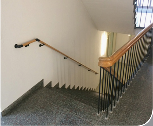
Verwaltungsgebäude: nachgerüstet mit wandseitigem Handlauf
