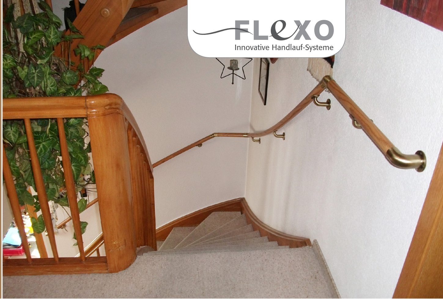
Innenhandlauf an einer Holzterre mit klassischem Treppenverzug
