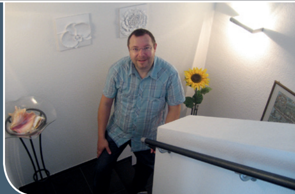
Durchlaufender Handlauf an der Podesttreppe innen
