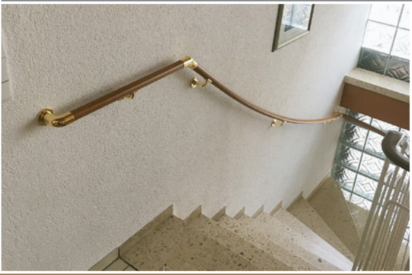
Geschwungener Handlauf mit langem Austritt
