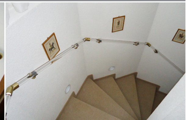
Handlauf in Plexiglas mit Beschlügen in Messing brüniert
