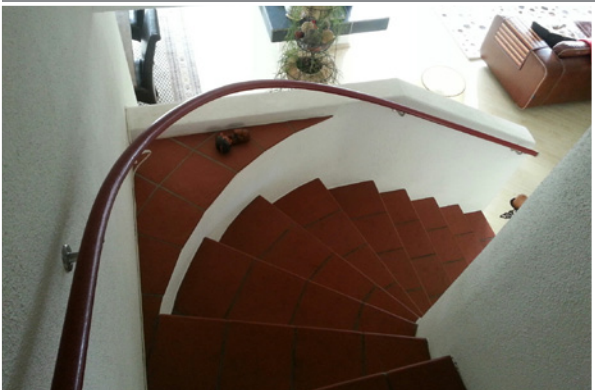
Geschwungener Handlauf, durchlaufend in den Ecken
