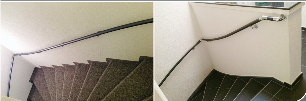
Handwerklich perfekter „Treppenverzug“ bei gewendelten Treppen
