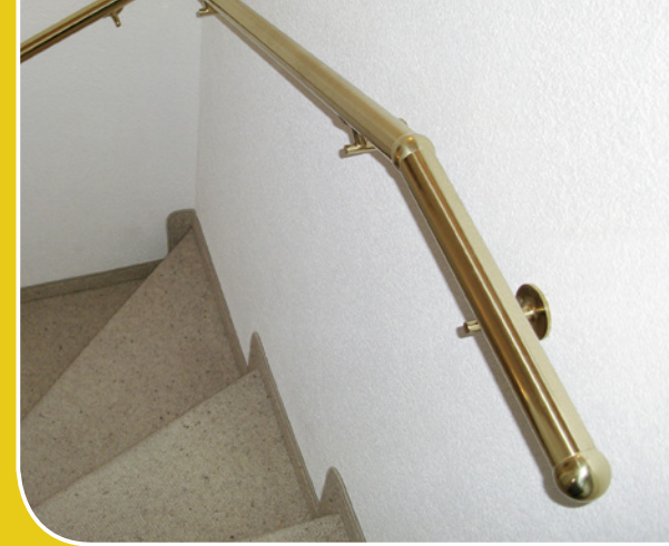
Handlauf in Messing, auch Stützen und Verbindungen massives Messing
