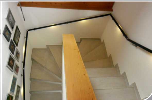
Punktuelle Beleuchtung bei einem 40 mm starken Handlauf
