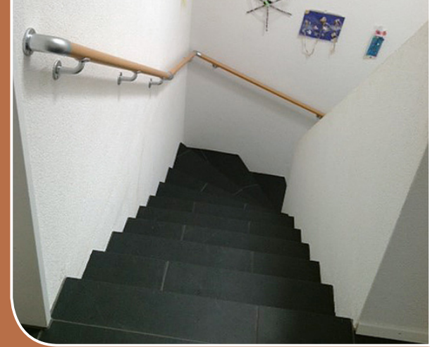
Richtiger Treppenverzug bei einer 1/4-gewendelten Treppe
