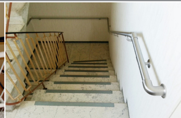
Durchlaufender Handlauf an einer Podesttreppe
