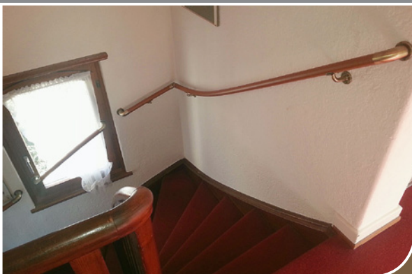
Durchgehender Handlauf, das Fenster wurde mit einbezogen
