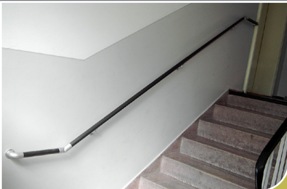
Abschluss nach Norm, 30 cm über die Stufe geführt
