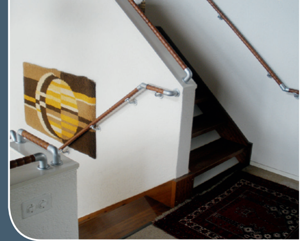
Handläufe an beiden Seiten einer Podesttreppe
