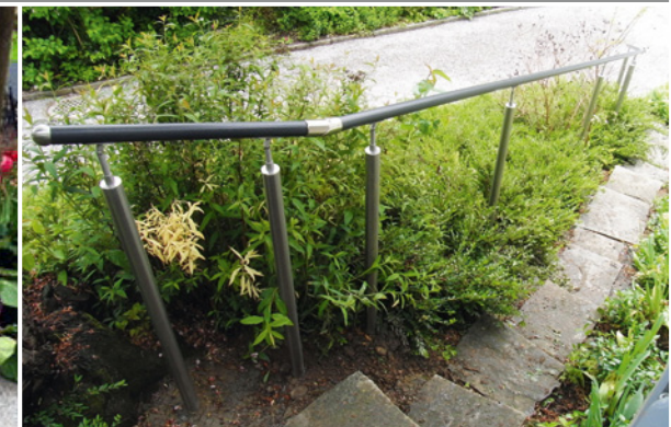
Dunkelgrauer Handlauf, Ø 35 mm, mit taktilen Elementen
