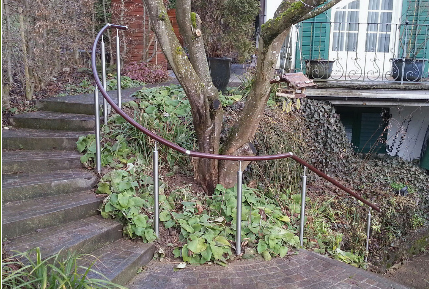
Handlauf in Mahagoni dunkel, Ausführung nach Norm, durchlaufend und mit Handlauf-Knick
