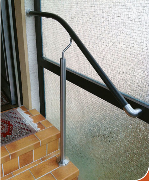
Speziellösung vor einer überdachten Hauseingangstüre
