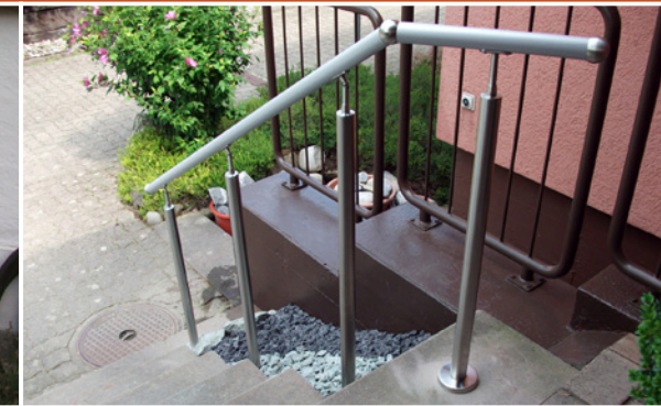
Handlauf mit Knick nach Norm, schräg auslaufend
