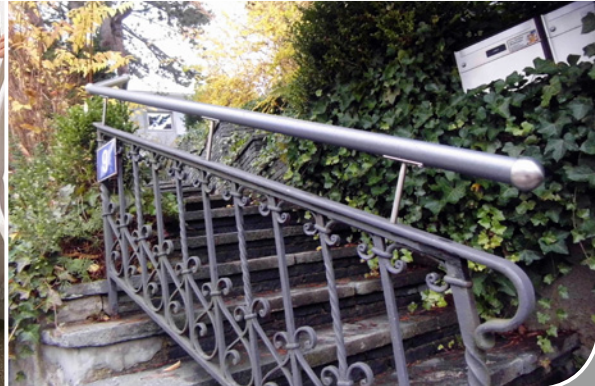
Geländererhöhung durch aufgesetzten Handlauf in Anthrazitgrau
