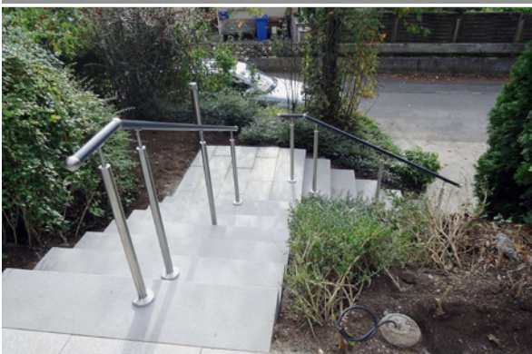
Sicherer Halt durch mittig angeordneten Handlauf
