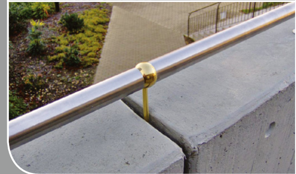
Erhöhung der Betonbrüstung durch Handlauf mit Beleuchtung
