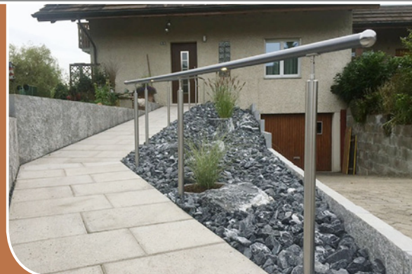
Beleuchteter Handlauf an langer Rampe
