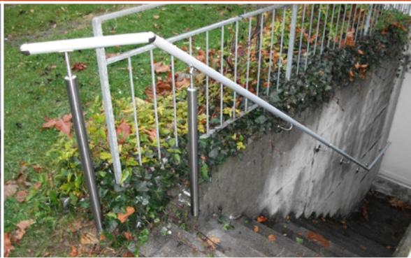
Betonierte und geschraubte Stützen, Wandhalter Edelstahl
