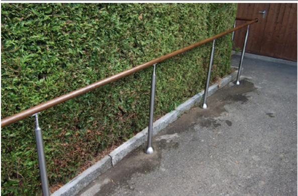
Im Asphalt eingebaute und verankerte Stützen in Chromstahl
