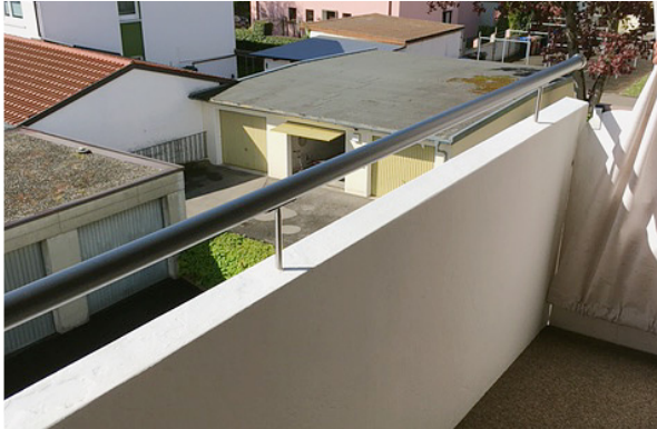
Handlauf als Brüstungserhöhung auf dem Balkon
