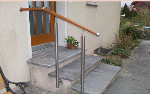
Sicherheit vor der Haustüre, mit seitlichen Stützen
