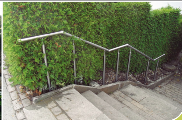
Durchlaufender Handlauf mit taktilen Kugelverbindern in Edelstahl
