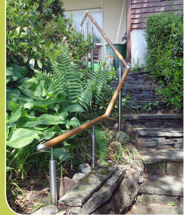
Einbetonierte Stützen in Edelstahl, Handlauf in Alu Dekor „Goldeiche“
