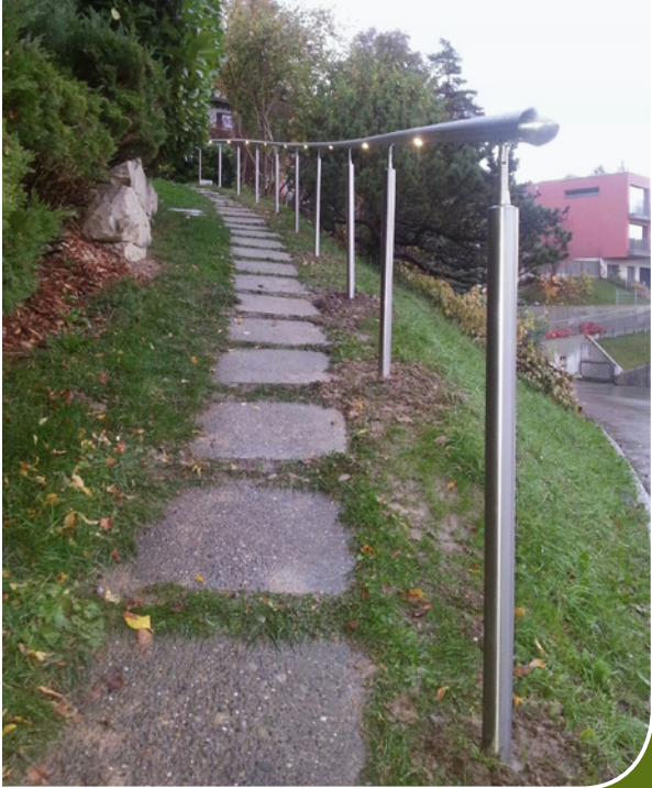
Langer Aufgang zum Wohnhaus mit Beleuchtung
