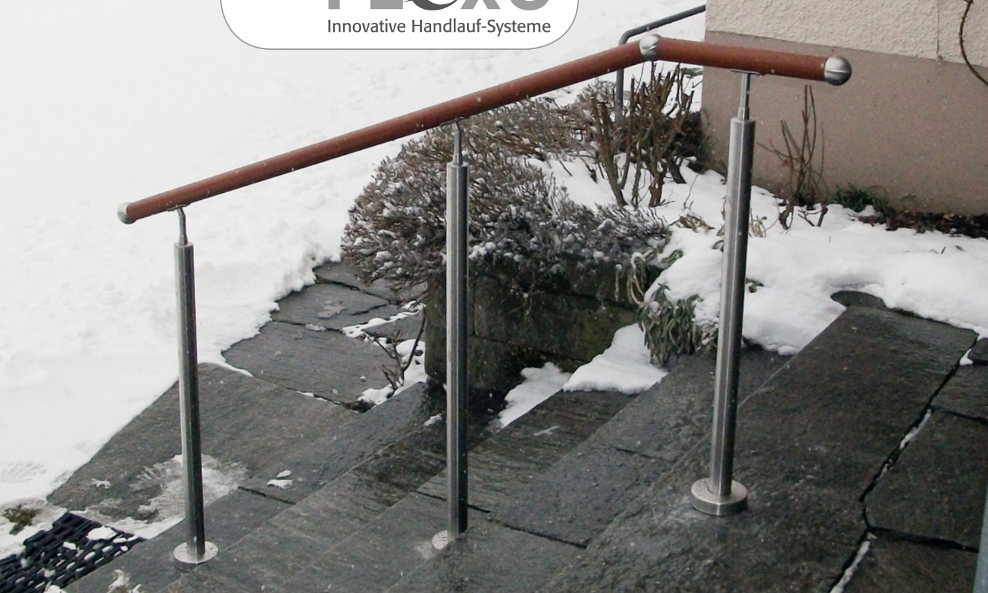
Mittiger Handlauf, oben waagrecht auslaufend, mit taktilem Kugel und Endkugel in Chromstahl
