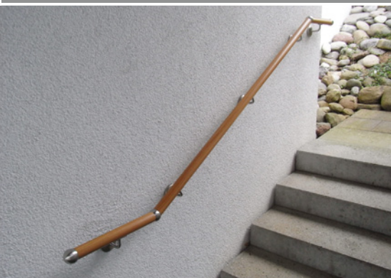
30 cm über die erste und letzte Stufe geführt
