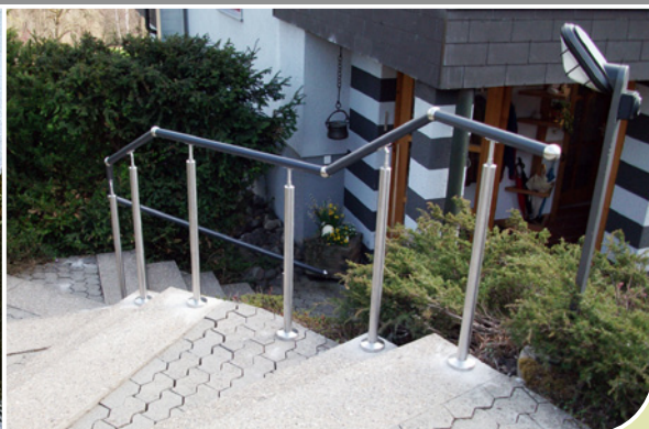
Durchlaufender Handlauf auch bei mehreren Einzelstufen
