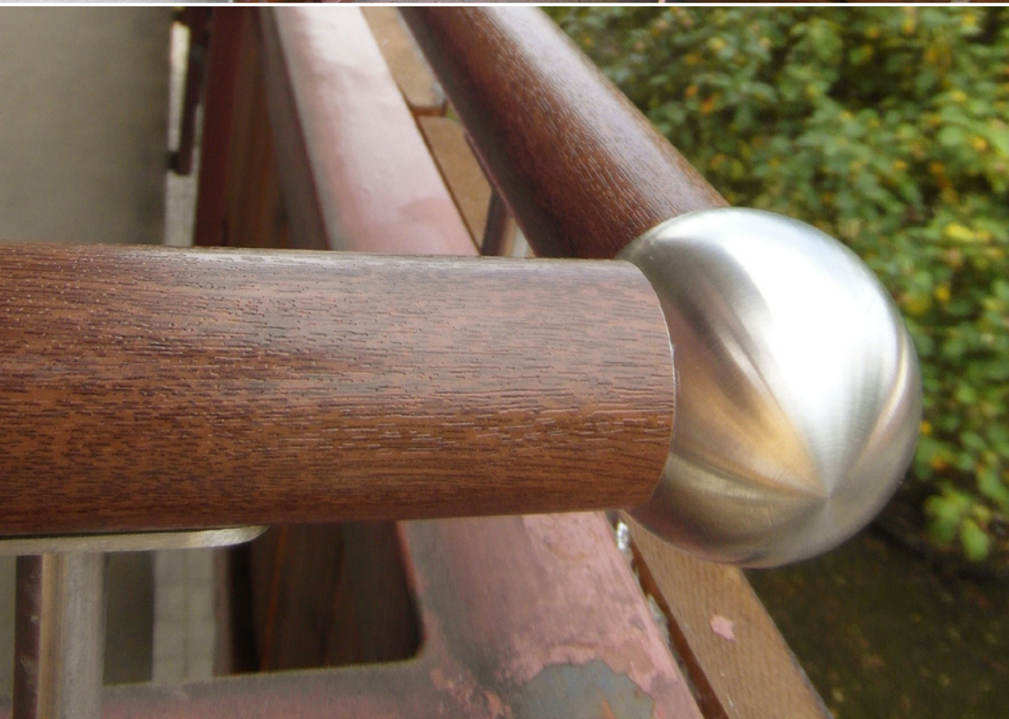
Balkone optisch passend auf die gesetzlich vorgeschriebenen Brüstungshöhen erhöht
