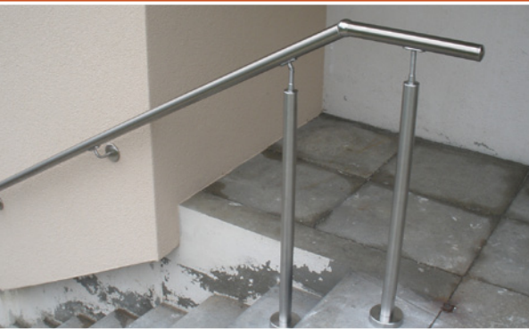
Handlauf an einer Hauswand mit Isolierung, Austritt nach Norm
