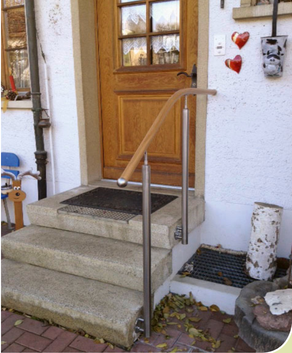
Handlauf im passenden Holzdekor, mit seitlich befestigten Pfosten
