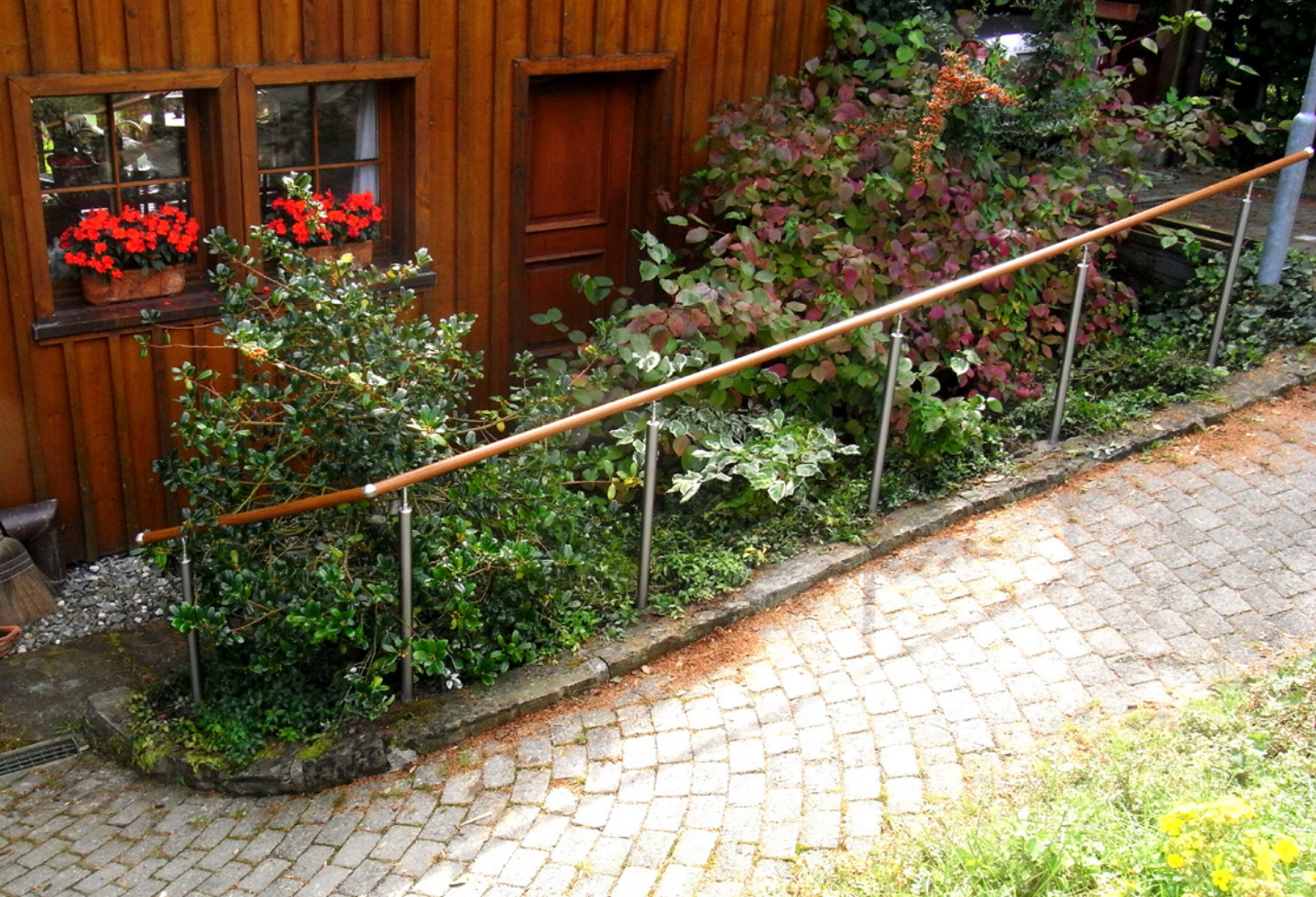
Aussenhandlauf in Aluminium in Dekor Balsamico mit einbetonierten Edelstahl-Stützen
